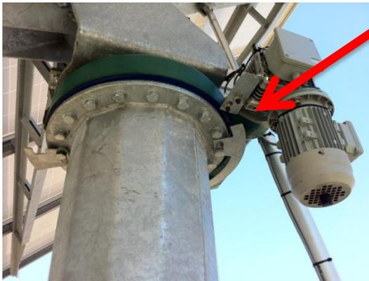
Colocar a Chapa de Posicionamento de forma a que comece a actuar a cerca de  $-10^{\circ}$ .
